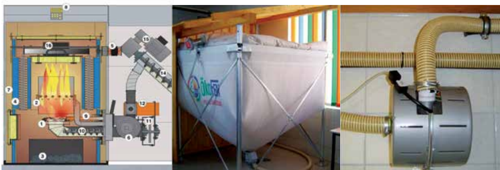
ΕΙΚΟΝΑ 1: Λέβητας βιομάζας με σύστημα τροφοδοσίας (πηγή: Davidson, 2006).
